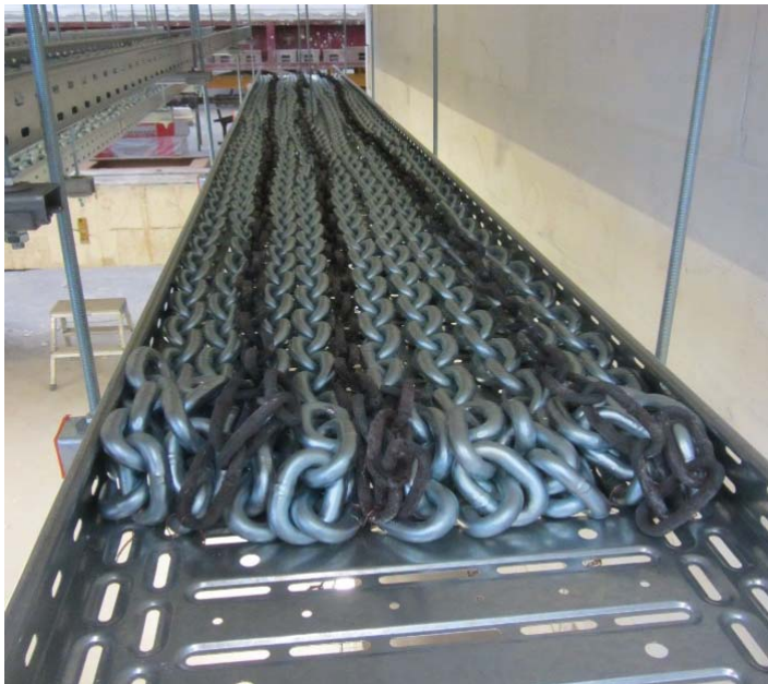
Bild 1: Belegung der Kabelrinnen mit Stahlketten
